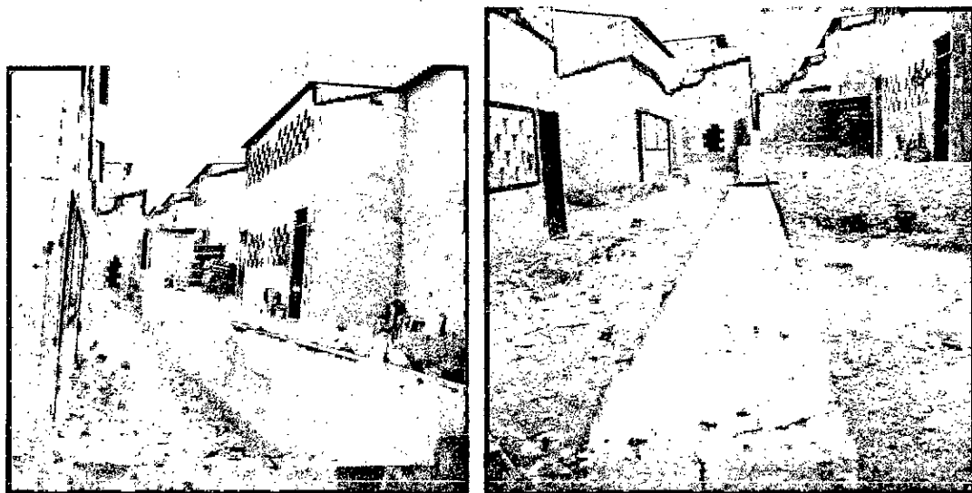
MURO SOBRE PATIOS MANZNA B
