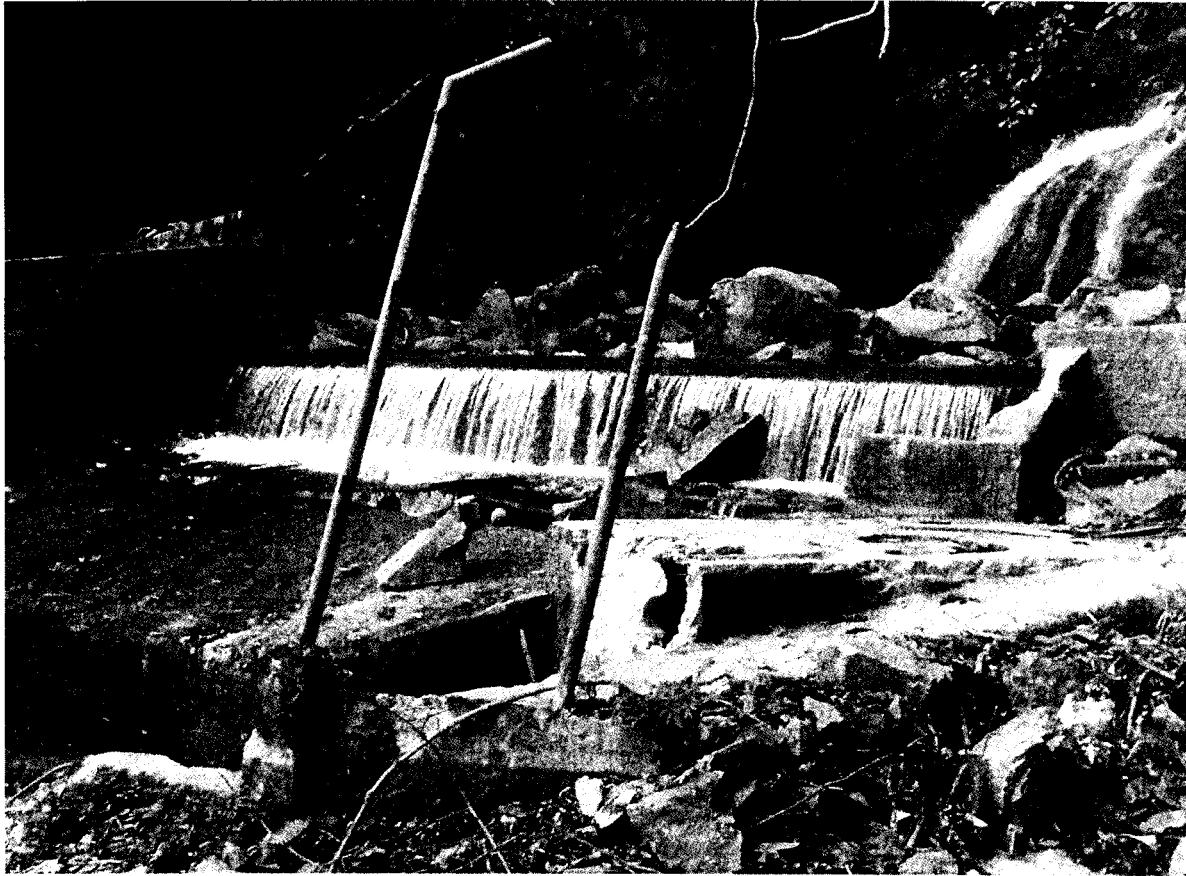
Estado actual de la Bocatoma
