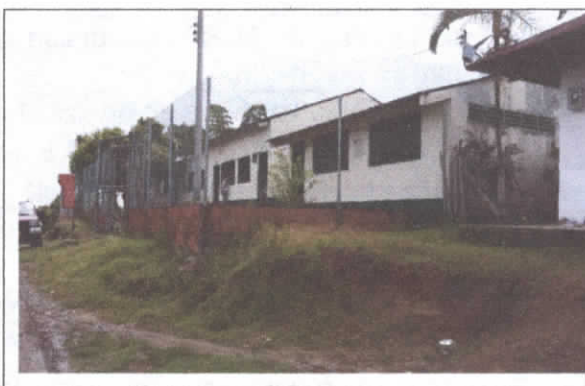
46. Costado que no hace parte del contrato
