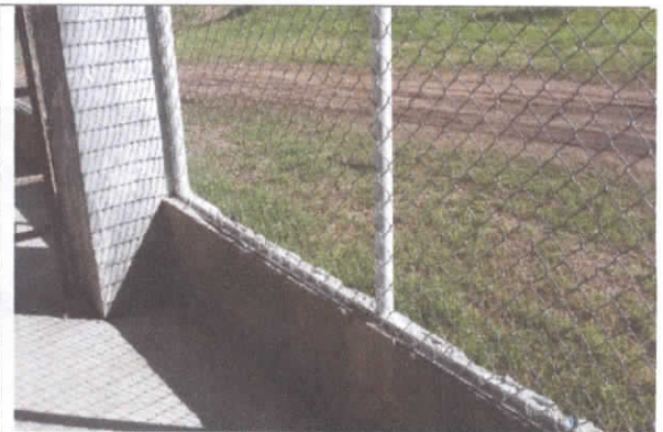
8. Malla eslabonada sobre antepecho, con platina parcial
