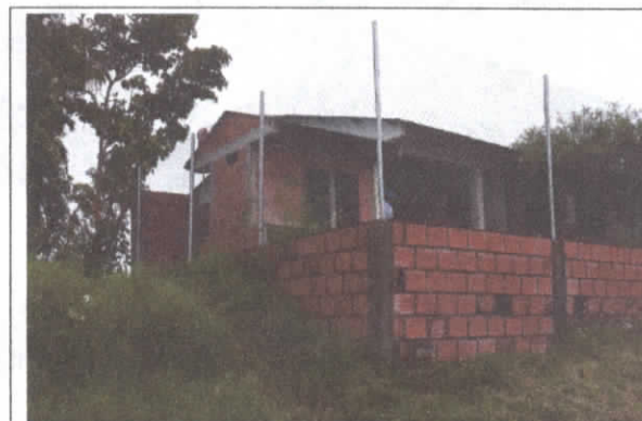
42. Culata del cerramiento
