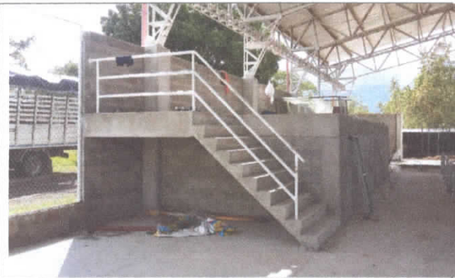
7. Escaleras de tarima
