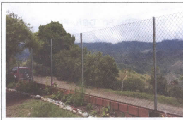
48. Malla eslabonada que carece de ángulo superior
