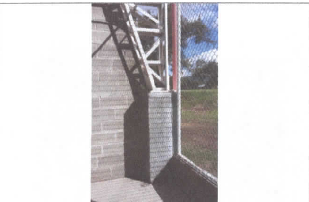
9. Pedestales para columna metálica
