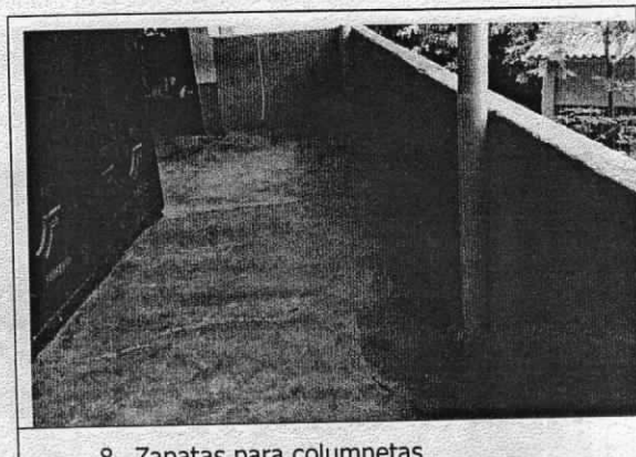
8. Zapatas para columnetas
