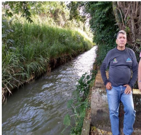
CANAL PARA GENERACION ENERGIA
