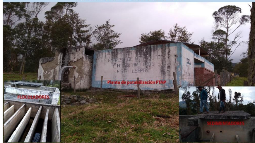
SISTEMA DE ACUEDUCTO DEL MUNICIPIO DE RONCESVALLES y LA EMPRESA DE SERVICIOS PUBLICOS ESPRON S.A E.S.P –TOLIMA. Octubre- 2018.
