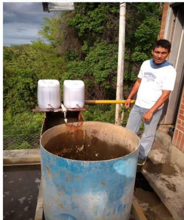
UNIDAD DE APLICACIÓN DE HIDROXIDO ALUMINIO
